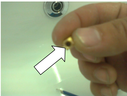
Rückschlagventil säubern, abtrocknen und mit dem runden Ende nach unten wieder einsetzen
